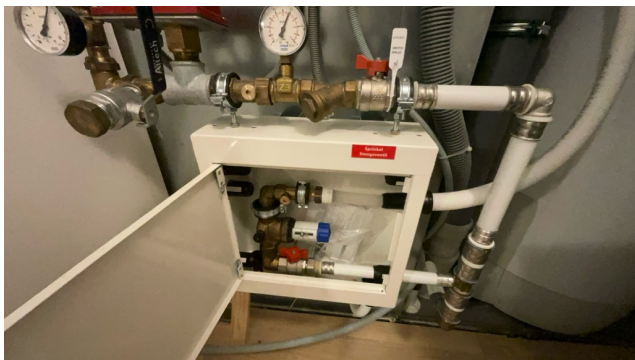
Besiktigelse av røropplegg.
