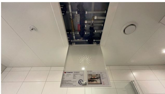
Besiktigelse av røropplegg.
