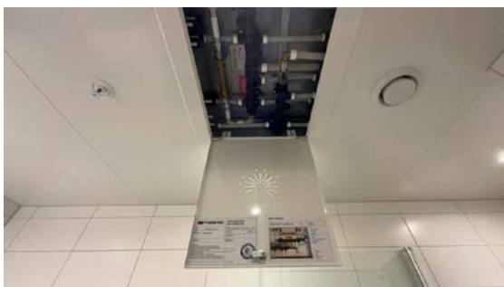
Besiktigelse av røropplegg.
