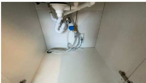
Besiktigelse av røropplegg.
