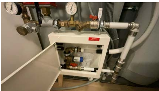
Besiktigelse av røropplegg.
