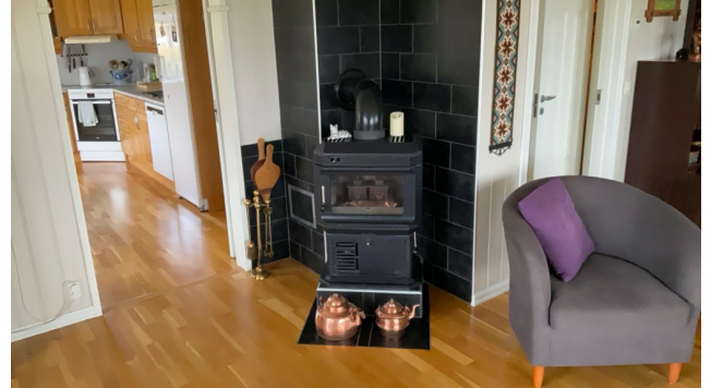
Flislagt pipe og brannmur.
