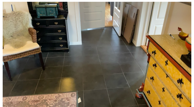
Flislagt gulv i hall.
