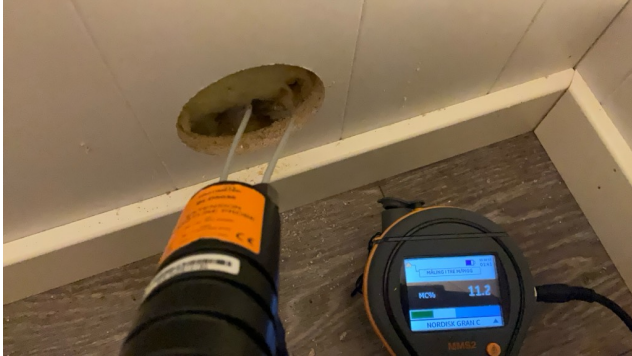
Ingen unormale forhold påvist i innlekket kjellervegg.
