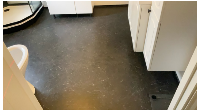
Belegg på gulv montert i 2014
