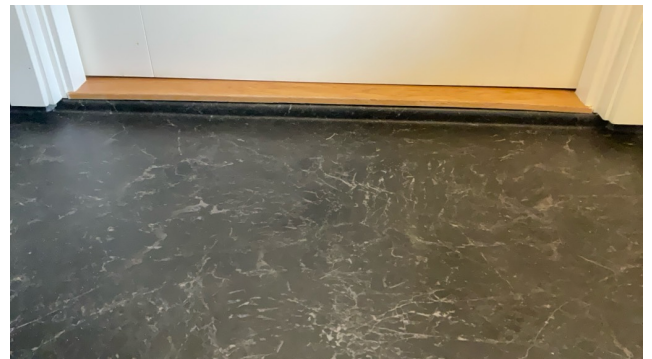
Oppbrett mot terskel
