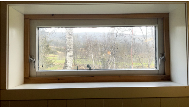
Kjellervindu fra innsiden.
