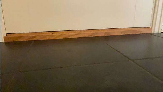
Tilluft under dørrblad
