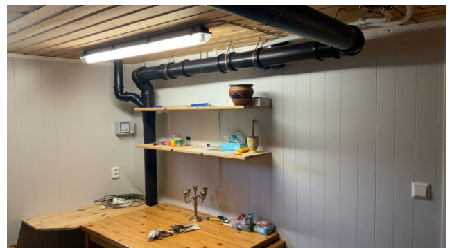
Avløpsrør i plast.
