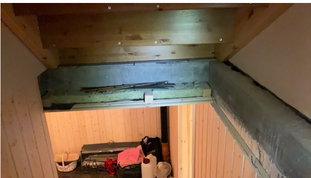
Betongdekke over kjeller.
