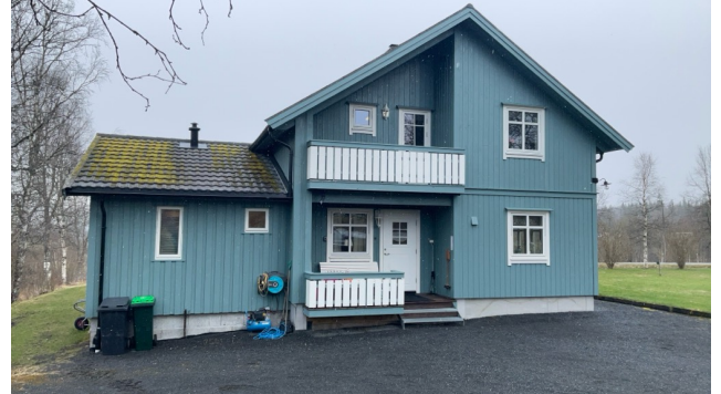
Mose på tak mot nord.
