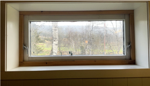
Kjellervindu fra innsiden.
