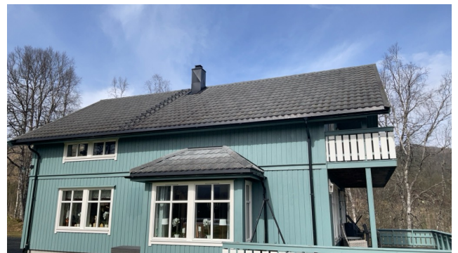
Taktekke mot sør
