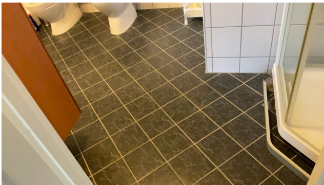
Fliser på gulv.
