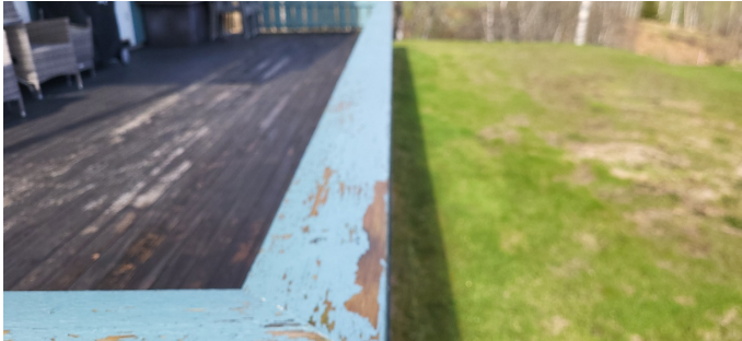
Malingsavflassing på dekkbord.
