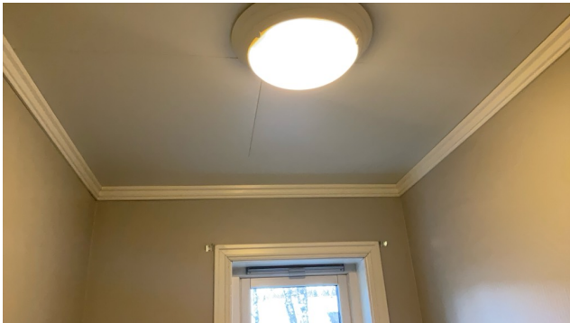
Ingen ventlering foruten åpning av vindu.
