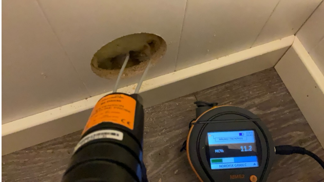
Ingen unormale forhold påvist i innlekket kjellervegg.
