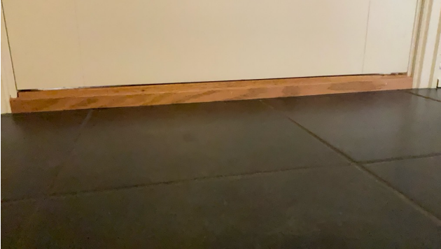
Tilluft under dørrblad
