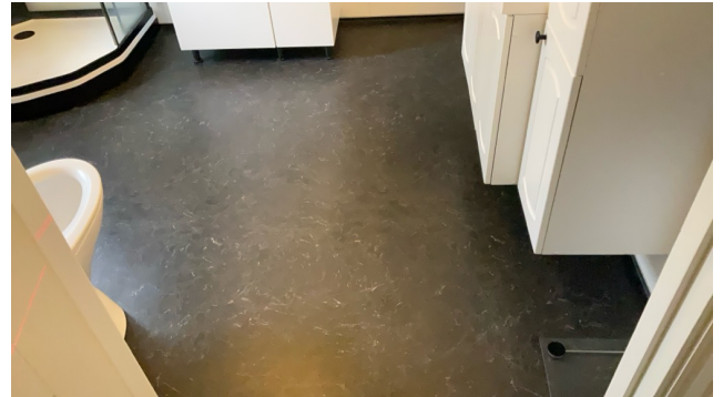
Belegg på gulv montert i 2024.
