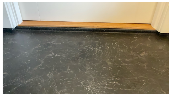
Oppbrett mot terskel
