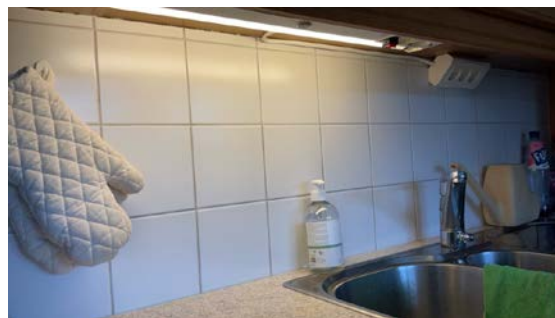
Fliser på vegg mellom over og underskap. HOVEDETASJE > KJØKKEN
