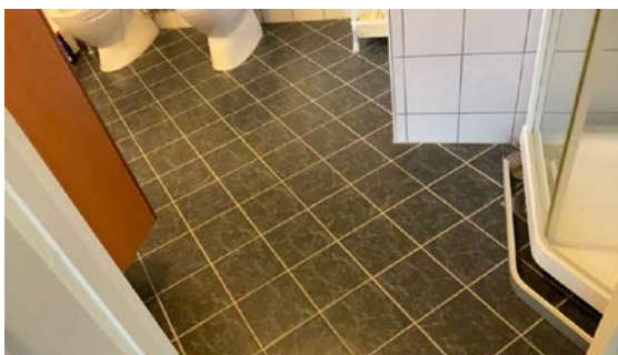
Fliser på gulv.
