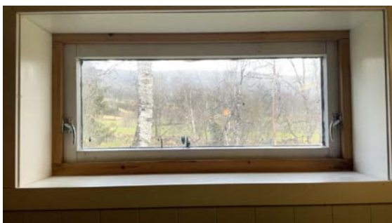
Kjellervindu fra innsiden.
