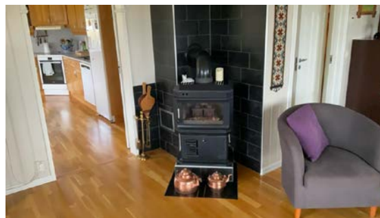
Flislagt pipe og brannmur.
