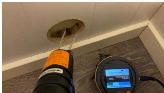
Ingen unormale forhold påvist i innlekket kjellervegg.
