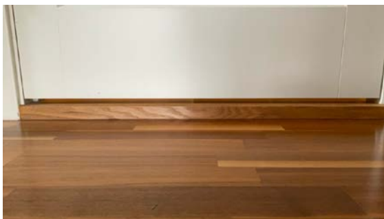
Tilluft over dørterskel. LOFTETASJE > BAD
