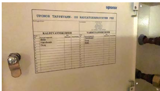
Kursoversikt rør i rør.
