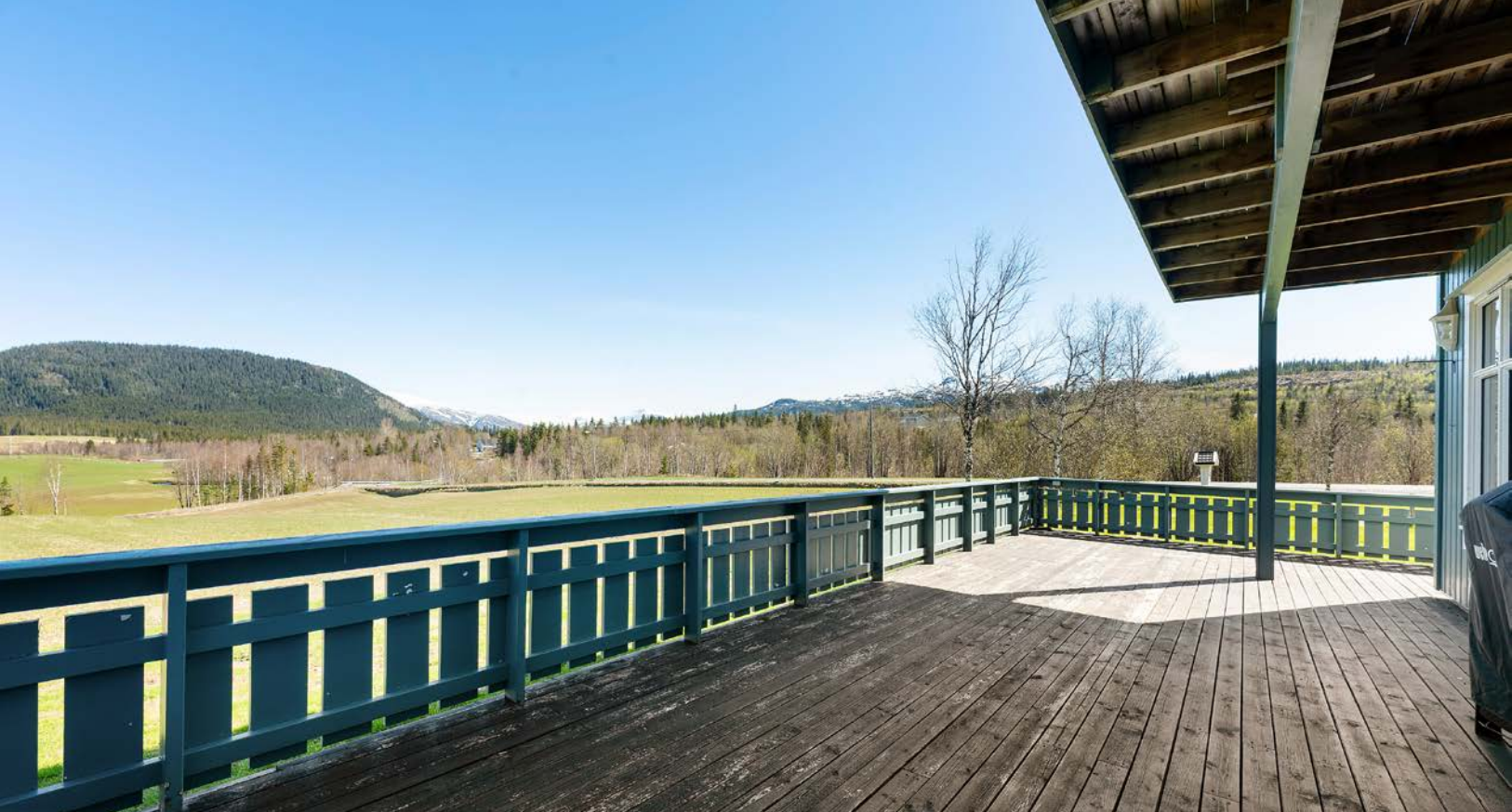
Hovedetasjen har en terrasse på ca. 41 m 2 , fundamentert på betong og trepilarer.
