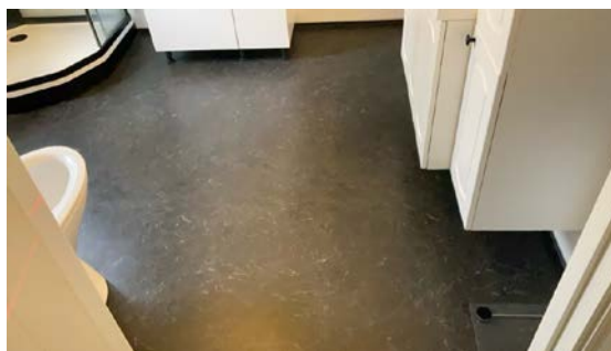
Belegg på gulv montert i 2014
