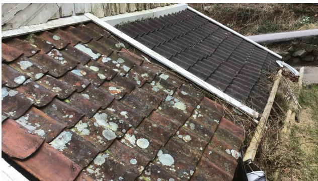
Tak over utvendig bod
