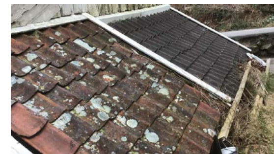
Tak over utvendig bod
