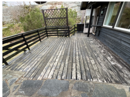
Terrassegulv med malingsflass.
