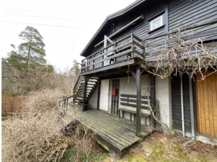
Trapp, gangvei og platting.
