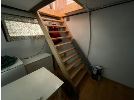
Trapp til underetasjen.
