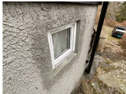
Kjellervindu fra byggeår
