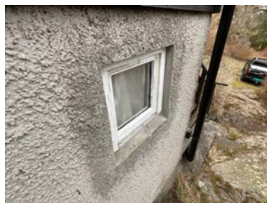
Kjellervindu fra byggeår
