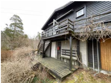
Trapp, gangvei og platting.
