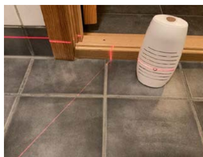
Flatt gulv utenfor dusjhjørne.
