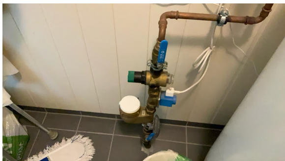
Innendig hovedstoppekran og vannmåler er plassert i teknisk rom.
