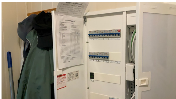
El-anlegg med automatsikringer. I hovedsak skjult ledningsnett. Sikringskapet er plassert i teknisk rom.
