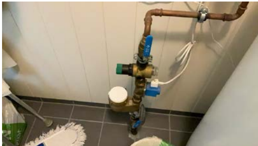
Innvendig hovedstoppekran og vannmåler er plassert i teknisk rom.
