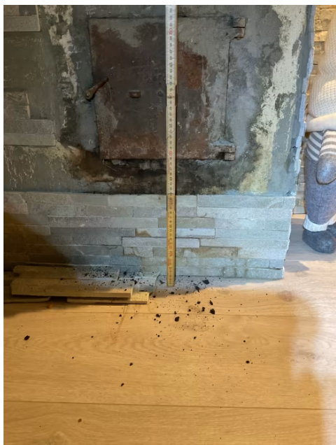
Avstand til brennbart fra sotluke.
