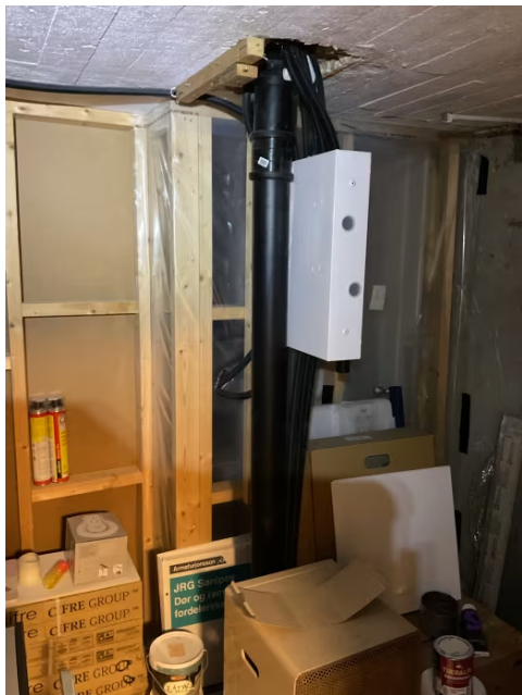
Avløpsstamme i uferdig bad kjeller.
