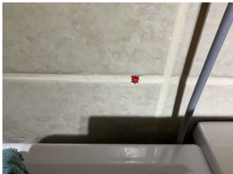
Plugger i fug over innredning.
