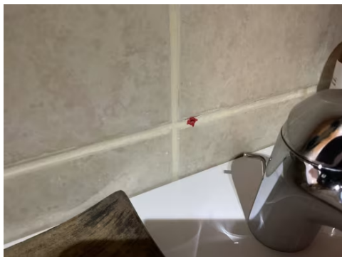
Plugger i fug over innredning.
