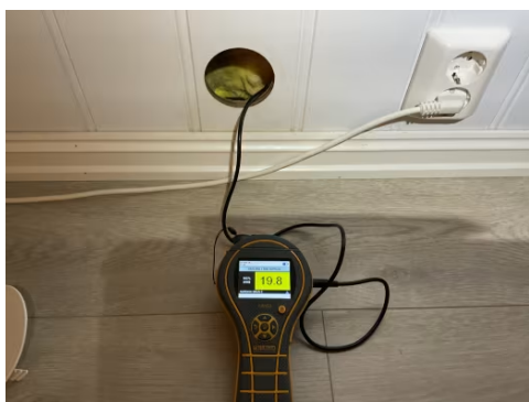
Fuktmåling i utforet vegg i kjeller.
