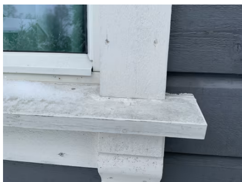
Utvendig belistning ned til vannbrett.
