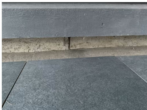
Skråkant av betong mot bolig.
