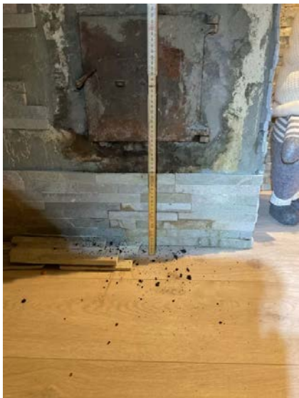
Avstand til brennbart fra sotluke.
