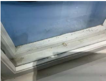
Eldre vindu i kjeller.
