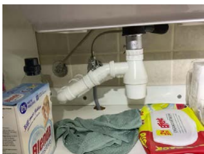
Avløpsrør bad 2. etg
