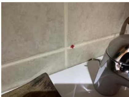
Plugger i fug over innredning.
