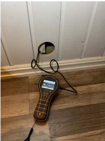
Fuktmåling i tilstøtende vegg.
