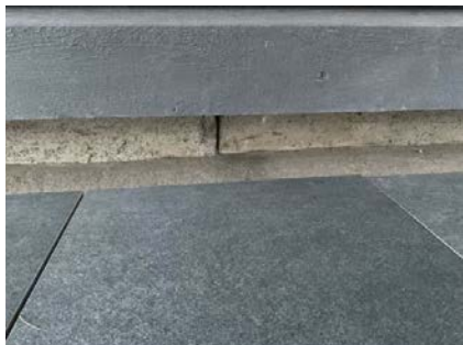
Skråkant av betong mot bolig.
