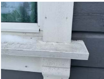
Utvendig belistning ned til vannbrett.
