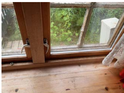
Sopp/råte fra kondens mellom glass, vindu på kjøkken.
