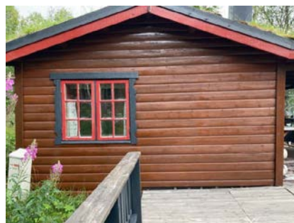
Bordkledning sørvegg.
