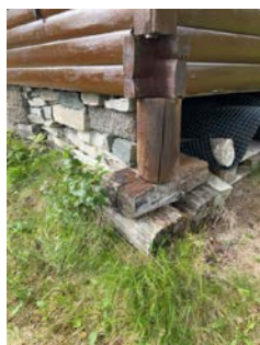
Søylepunkt hjørne mot nord-øst fundamentert på jernbanesviller.
