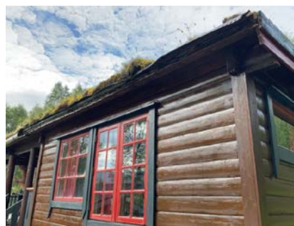
Manglete dekkbord mot sperrender.
