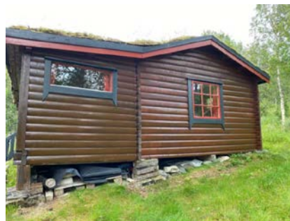
Bordkledning/tømmervegg mot nord.
