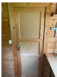
Dør inn til toalettrom tar i gulv.
