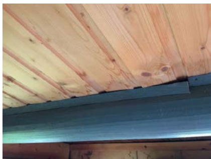
Panel ikke festet/fuktskjolder i panel.
