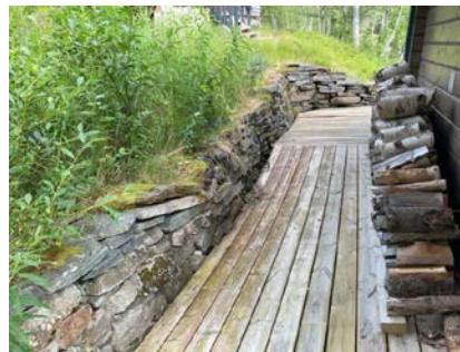
Støttemur av naturstein mot annek.
