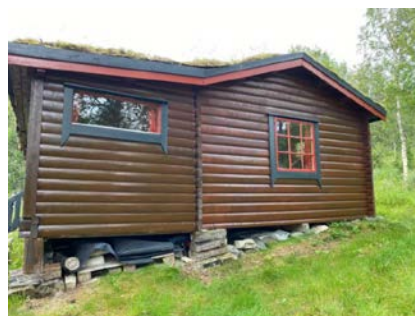
Bordkledning/tømmervegg mot nord.
