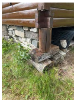
Søylepunkt hjørne mot nord-øst fundamentert på jernbanesviller.
