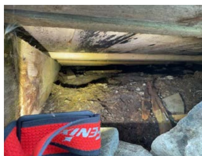
Krypkjeller inspisert fra nord side av bygget.
