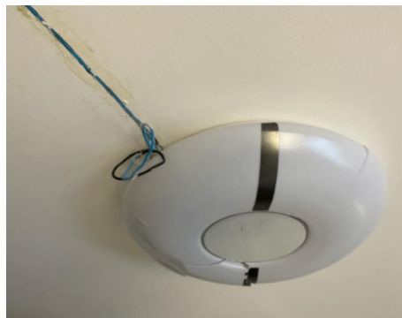
Taklampe på soverom i 2.etg framstår opplagt ufagmessig montert.
