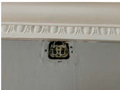
Åpent el.punkt oppunder tak på vegg mot soverom i 2.etg.
