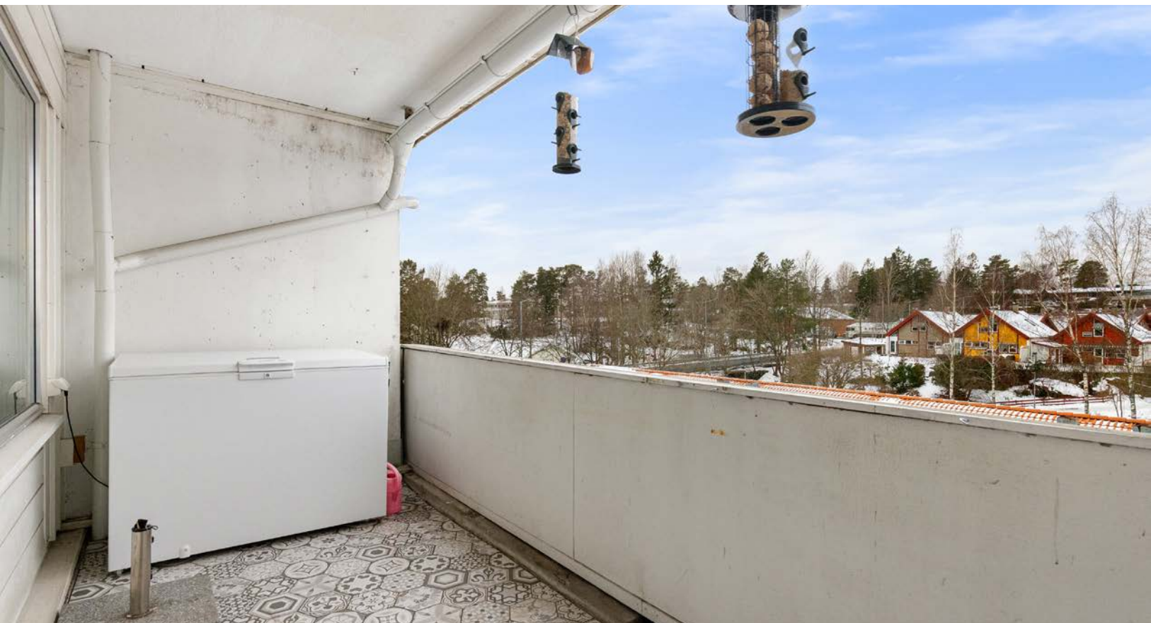
Her er det god plass til sittegruppe m.m. Det er montert strømuttak. Balkongen er overbygget, noe som øker bruksverdien.
