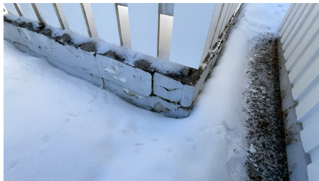
Mur for rekkverk
