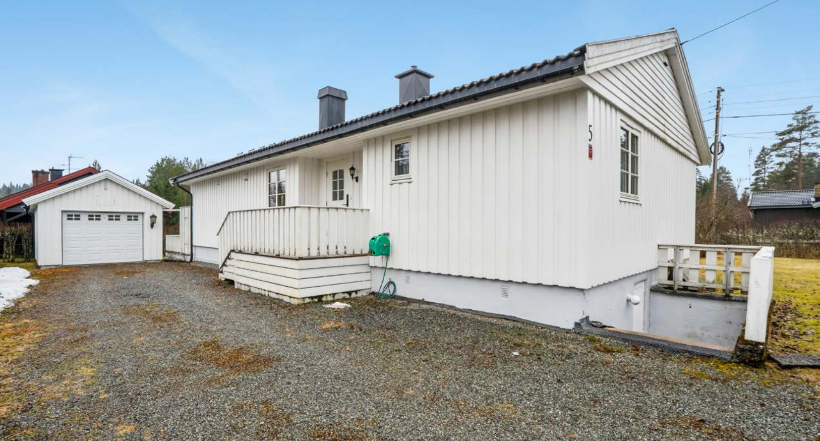
Eneboligen er fra 1978, og består 1.etasje og kjeller.
