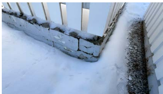
Mur for rekkverk
