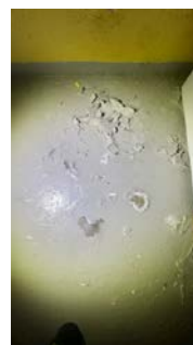
Saltutslag og utettheter- ikke tettesjikt
