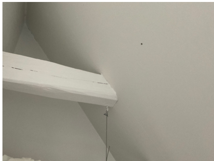
Bjelke-gjennomføring i tak.
