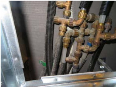
Rør opplegg i kjeller.
