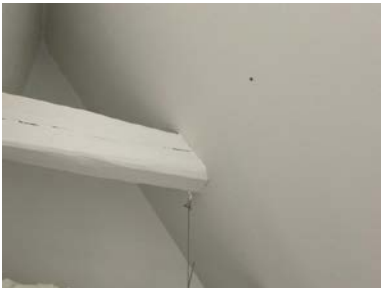
Bjelke-gjennomføring i tak.
