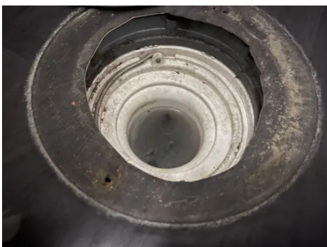
Belegg ikke klemt med klemring.
