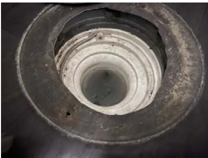
Belegg ikke klemt med klemring.
