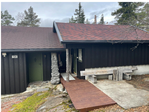
Fritidsboligen med tilbygg fra 1991 (tilbygg fra 2009)
