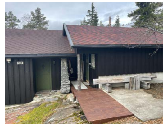
Fritidsboligen med tilbygg fra 1991 (tilbygg fra 2009)
