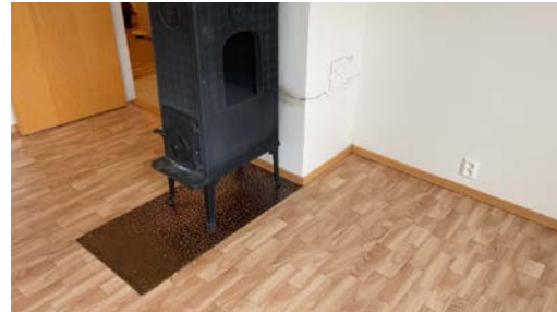
Sprekk i pipe ved sotluke i 8 M.
