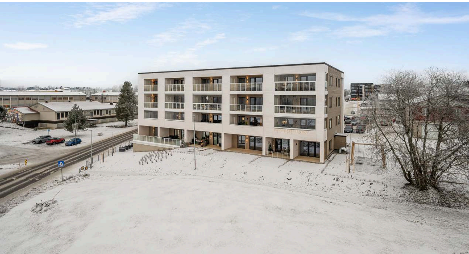
Leilighetsbygget ligger meget sentralt til i Løten kommune, med gangavstand til det meste.
