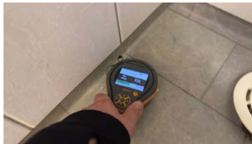
Kontroll av fukt, ingen forhøyede fuktverdier ble målt i gulvet.
