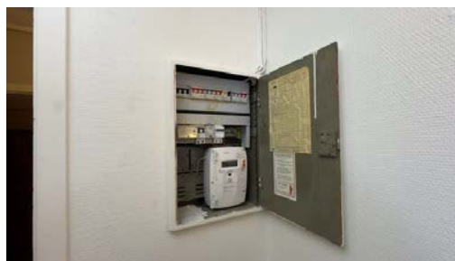
Kontroll av el-skap og kursfortegnelse.
