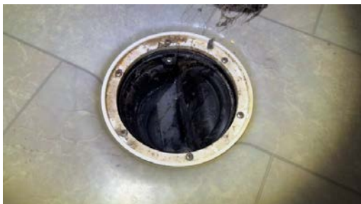
Kontroll av sluk.
