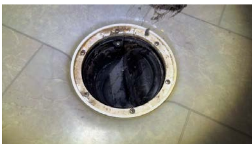
Kontroll av sluk.
