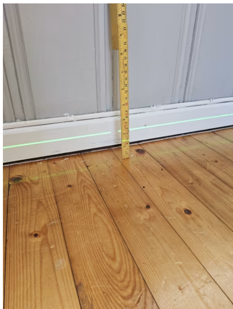
Bilde viser måling av etasjeskiller.
