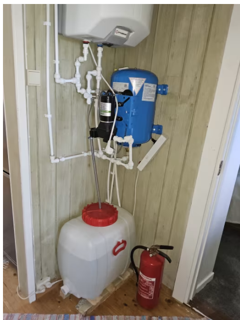
Bilde viser vanntank og vannpumpe.
