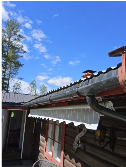
Bilde viser takrenner.
