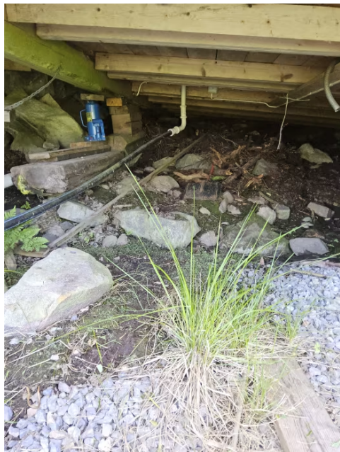
Bilde viser krypkjeller.
