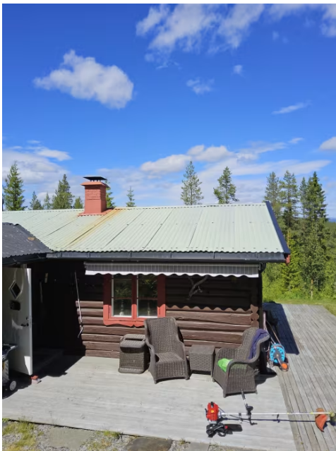
Bilde viser taktekking.
