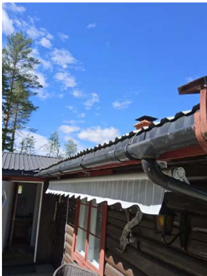
Bilde viser takrenner.
