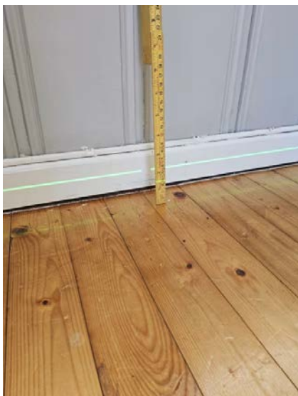
Bilde viser måling av etasjeskiller.
