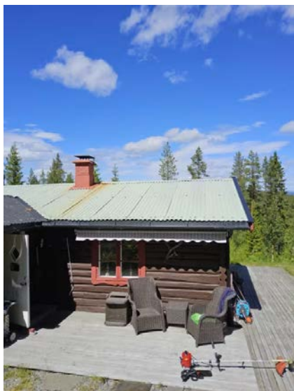
Bilde viser taktekking.
