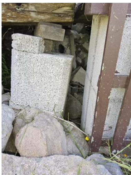
Bilde viser fundamenter.
