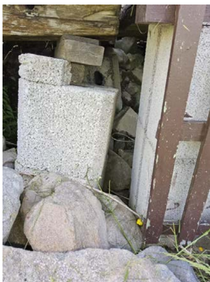
Bilde viser fundamenter.
