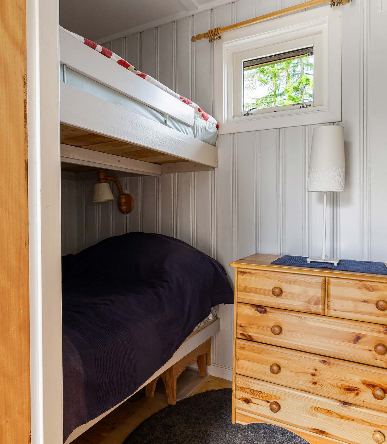
Det andre soverommet som ligger i tilknytning til gangen er innredet med plassbygd køye, med sengeplasser for 4 små. Rommet er byggmeldt for varig opphold. Det gjøres oppmerksom på at vindusstr. ikke tilfredstiller krav til rømning.
