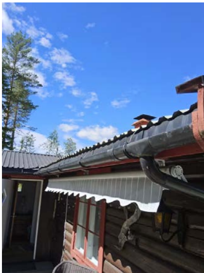
Bilde viser takrenner.
