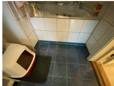
Sluk under boblekar var ikke tilgjengelig for inspeksjon
