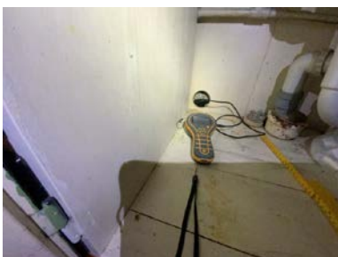
Ved fuktmåling ble det registrert tørre verdier.
