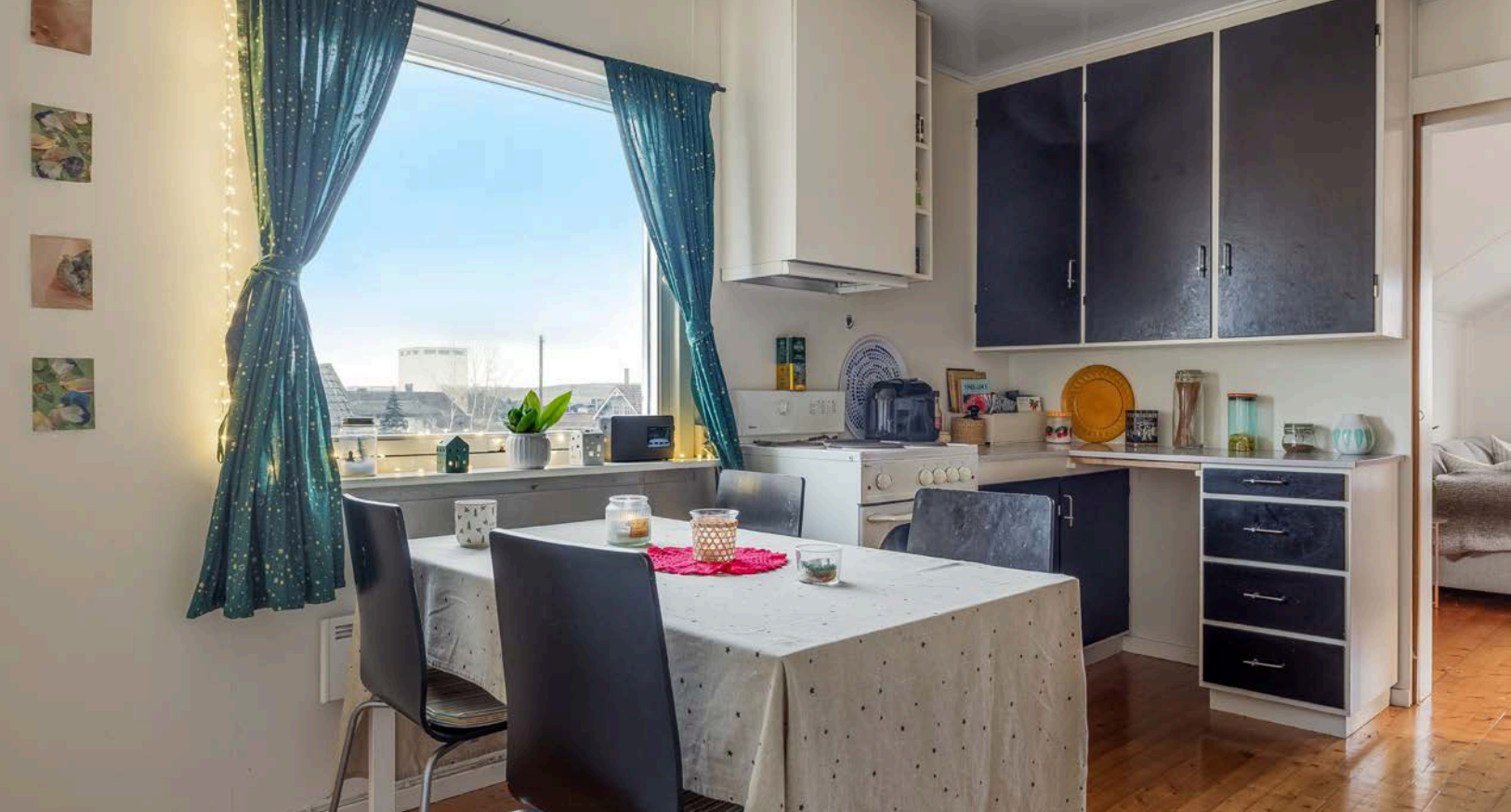
Eldre kjøkkeninnredning i 2. etasje med glatte malte fronter, laminert benkeplate og benkebeslag med nedfelt oppvaskum.
