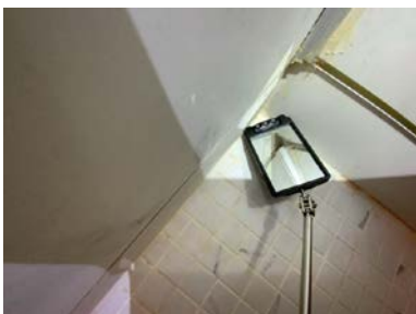
Utett hjørnelist for baderomplater.
