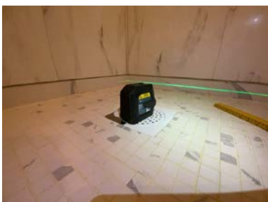
Fallforhold har avvik i forhold til referansenivå.
