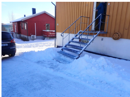
Trapp i strekkmetall foran hovedytterdør.
