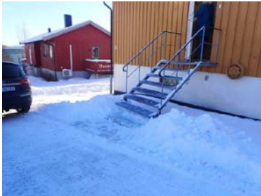
Trapp i strekkmetall foran hovedytterdør.
