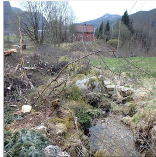
Fig 4.4: Parti av bekken som må ryddes/åpnes.
