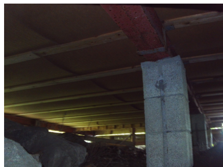
Pilarer av lettklinkerblokker
