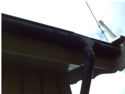
Plastrenner i fra byggeåret.
