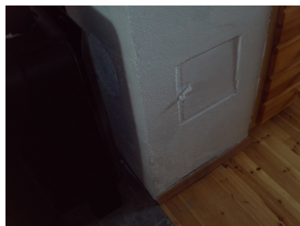
Sotluke i mot kjøkken.
