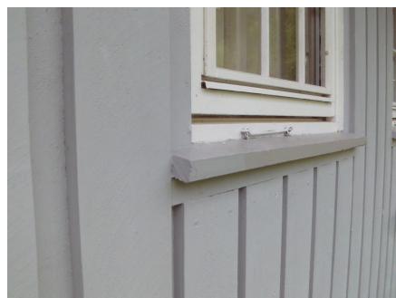
Deler av kledningen med tilhørende belistninger.
