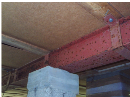
Jernbjelke i mellom pilarer.
