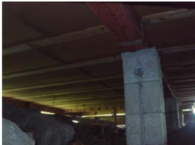
Pilarer av lettklinkerblokker
