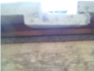
Noe tilgang på luft bak kledningen.
