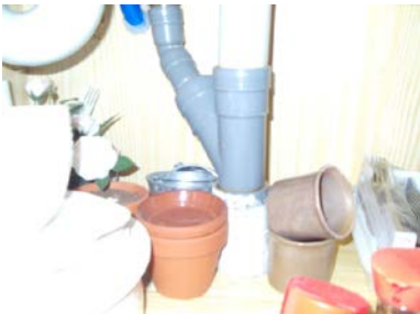
Avløpsrør i kjøkkenbenken.
