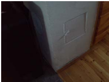
Sotluke i mot kjøkken.
