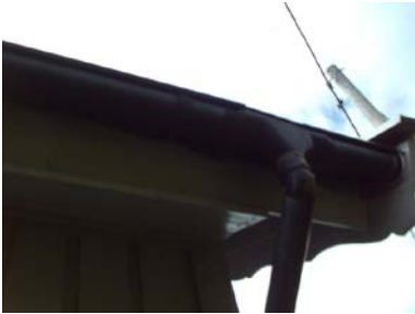
Plastrenner i fra byggeåret.
