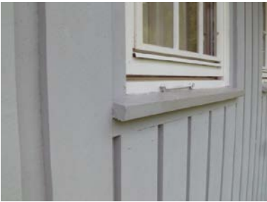
Deler av kledningen med tilhørende belistninger.
