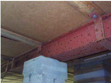
Jernbjelke i mellom pilarer.
