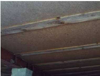
Deler av underliggende stubbloft
