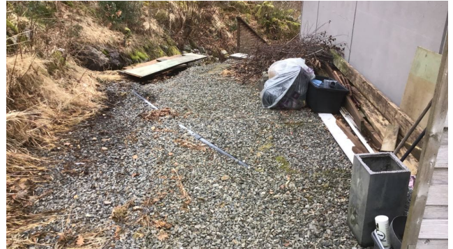
Ny drenering på baksiden
