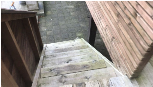
Mangler rekkverk
