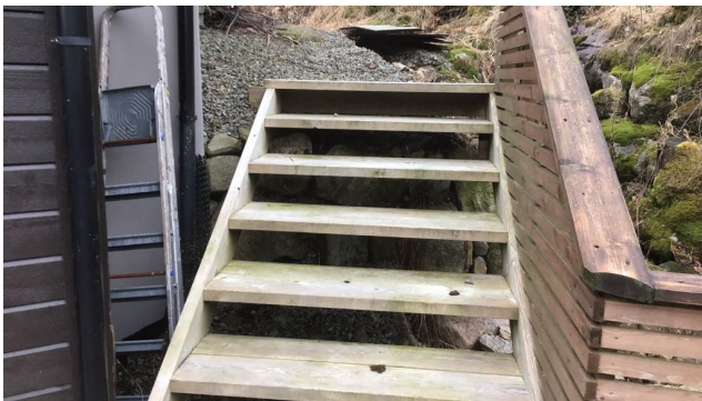
Mangler rekkverk
