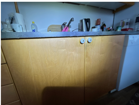
Begynnende svelleskade på benkeplate ved oppvaskum og oppvaskmaskin
