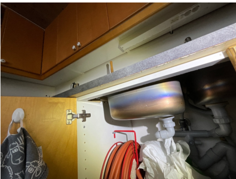
Begynnende svelleskade på benkeplate ved oppvaskum og oppvaskmaskin
