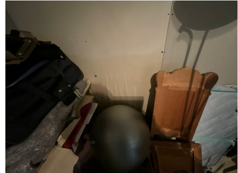
Tegn til noe fuktproblem på gipsplater i bod
