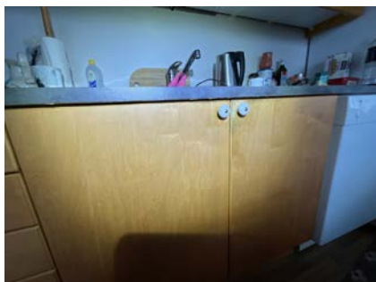
Begynnende svelleskade på benkeplate ved oppvaskkum og oppvaskmaskin
