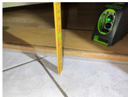
Måling av fallforhold på gulv. Topp laserstrek viser 5mm.
