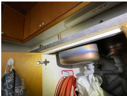
Begynnende svelleskade på benkeplate ved oppvaskkum og oppvaskmaskin
