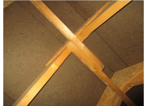
Plassbygget sperrekonstruksjon.
