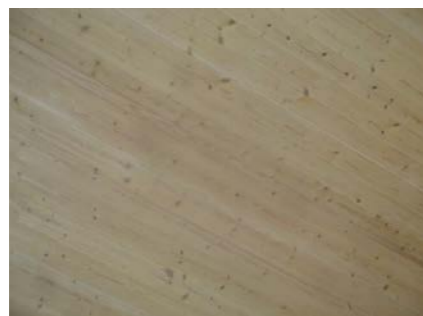
Lukket takkonstruksjon i stue kjøkken.
