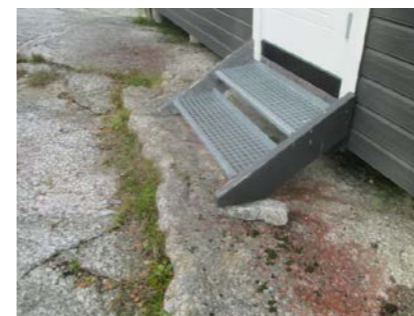
Mindre trapp ved inngangsparti.
