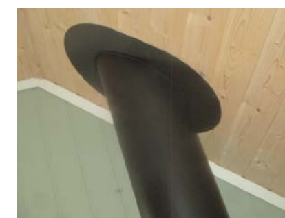
Takgjennomføring på hems.
