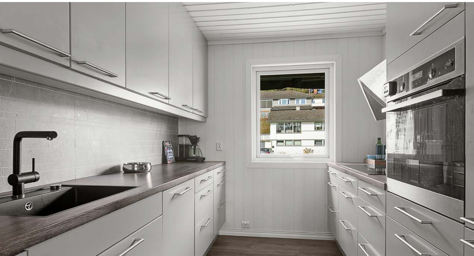
Nedfelt induksjonstopp (Electrolux), komfyr (Electrolux), kjølfrys (Samsung), oppvaskmaskin (Asko) og ventilator.
