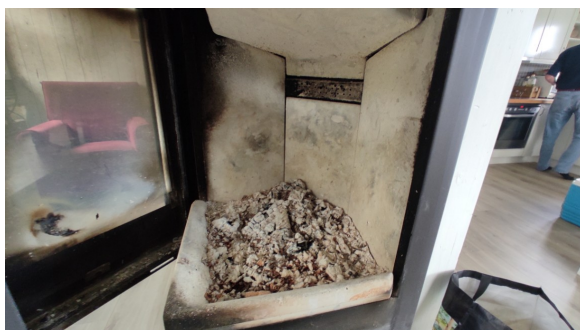
Kontroll av ildsted.
