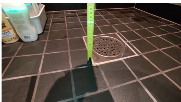
Kontroll av røropplegg
