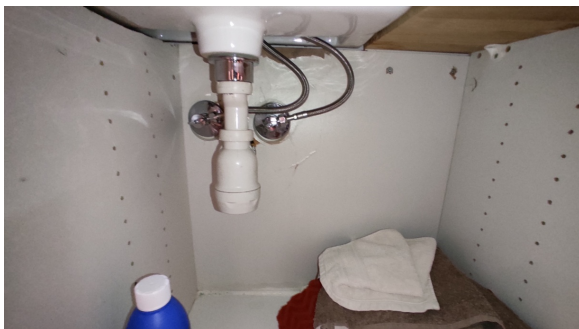
Kontroll av røropplegg.
