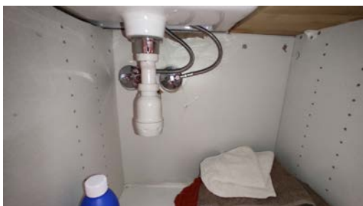
Kontroll av røropplegg.
