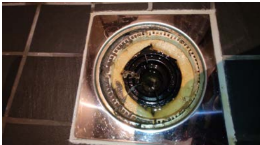
Kontroll av sluk.
