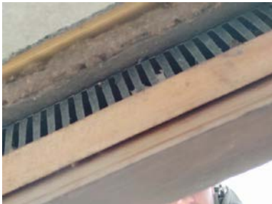
Kontroll av musesperre.
