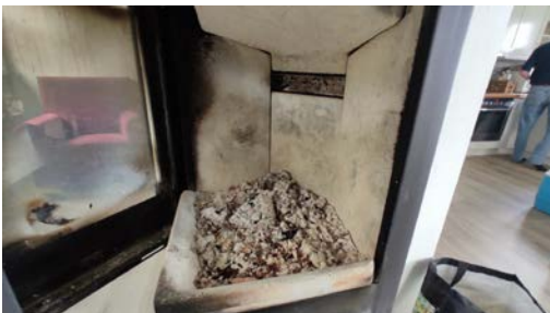
Kontroll av ildsted.
