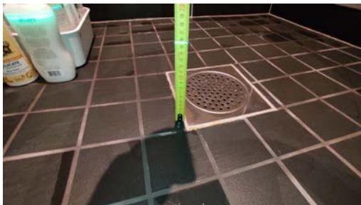
Kontroll av røropplegg
