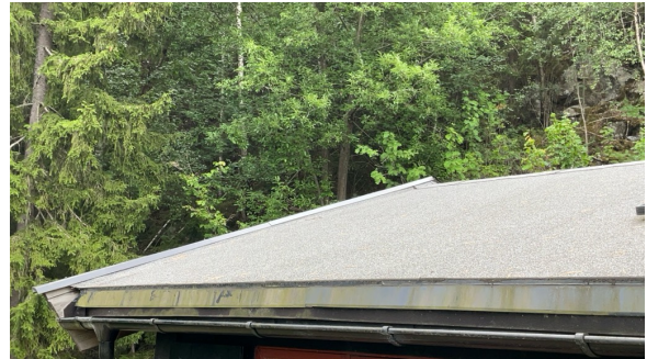
Del av taktekking.
