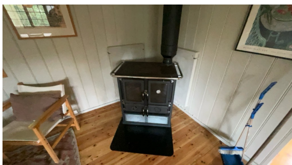
Montert ovn i stue.
