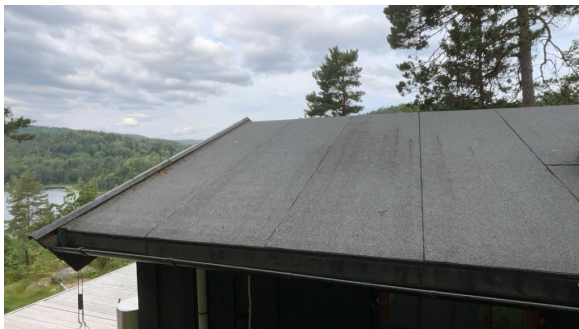
Del av taktekking.
