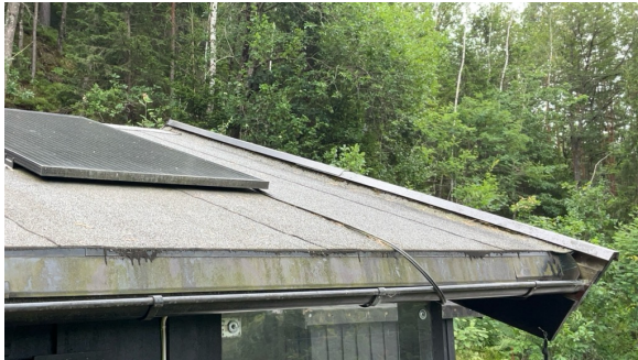
Del av taktekking.
