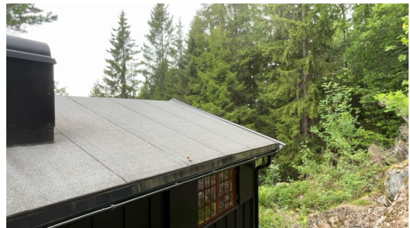
Del av taktekking.
