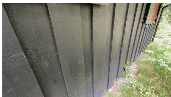
Del av vegg.
