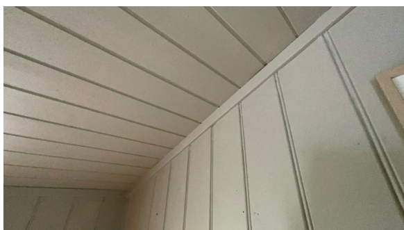
Del av vegg - tak.
