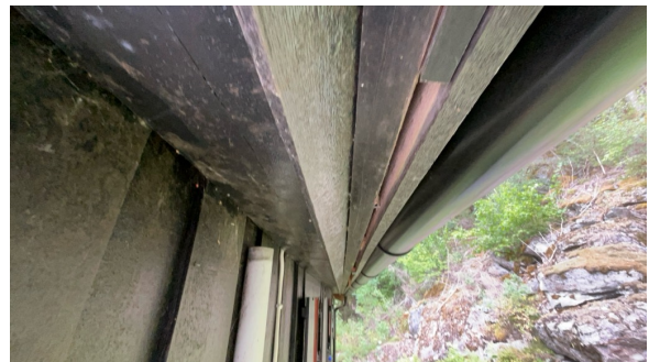
Del av takkonstruksjon.
