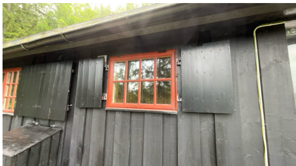
Eksempel på vindu i yttervegg.
