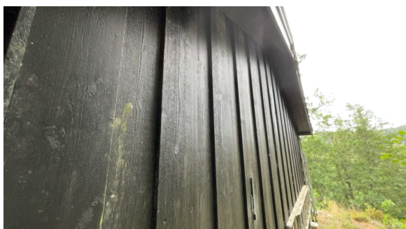
Del av vegg.
