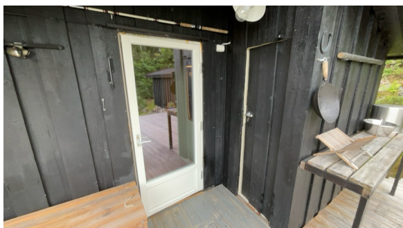
Hovedinngangsdør og dør inn til toalettrom.
