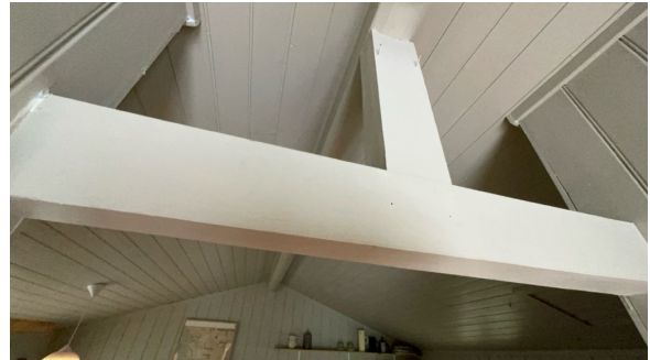
Tak sett fra innsiden.
