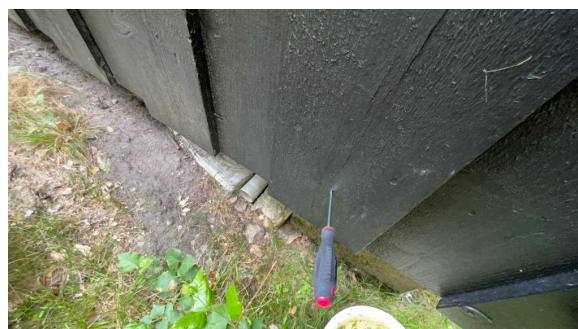
Del av vegg.
