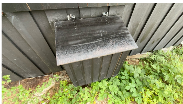
Utvendig skap til gass flasker.
