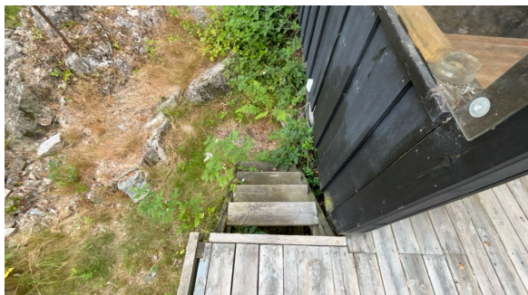
Trapp ned fra terrasse.
