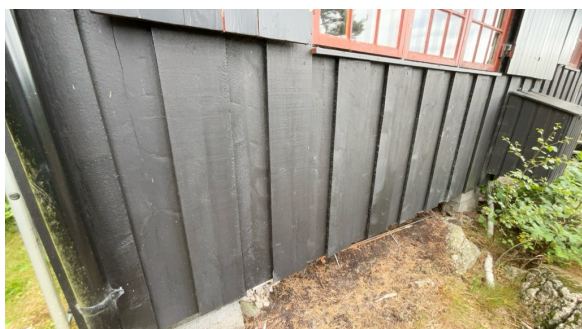
Del av vegg.
