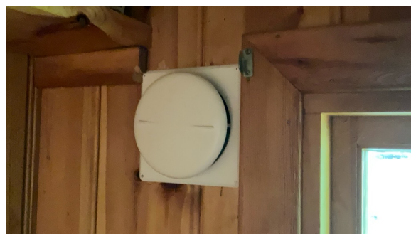
Eksempel på montert ventil i vegg.
