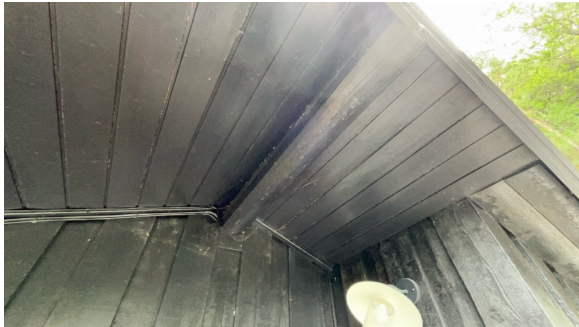
Konstruksjon sett fra terrasse.
