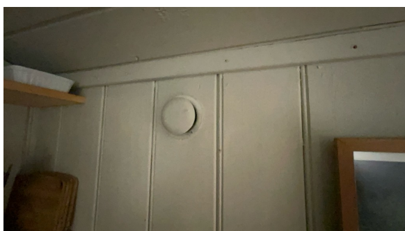
Eksempel på montert ventil i vegg.
