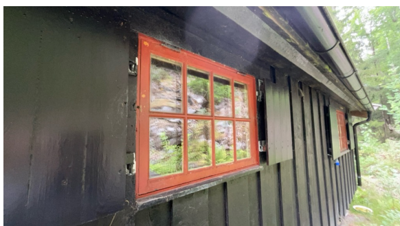
Eksempel på vindu i yttervegg.
